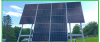
Vermont, EE. UU. Sistemas solares residenciales sin conexión a la red Propietario de vivienda en Vermont obtiene la independencia energética de la red eléctrica. Solución: sistema multiclúster sin conexión a la red eléctrica que incluye inversores/cargadores XW+, controladores de carga MPPT 80 600 y baterías compatibles.
